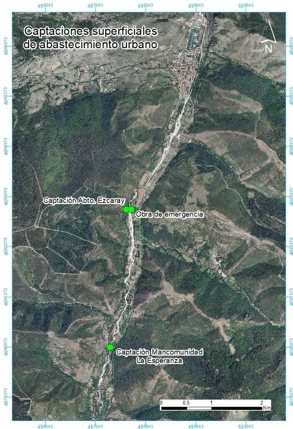
Figura 7.1.3. Principales captaciones superficiales de abastecimiento urbano.
