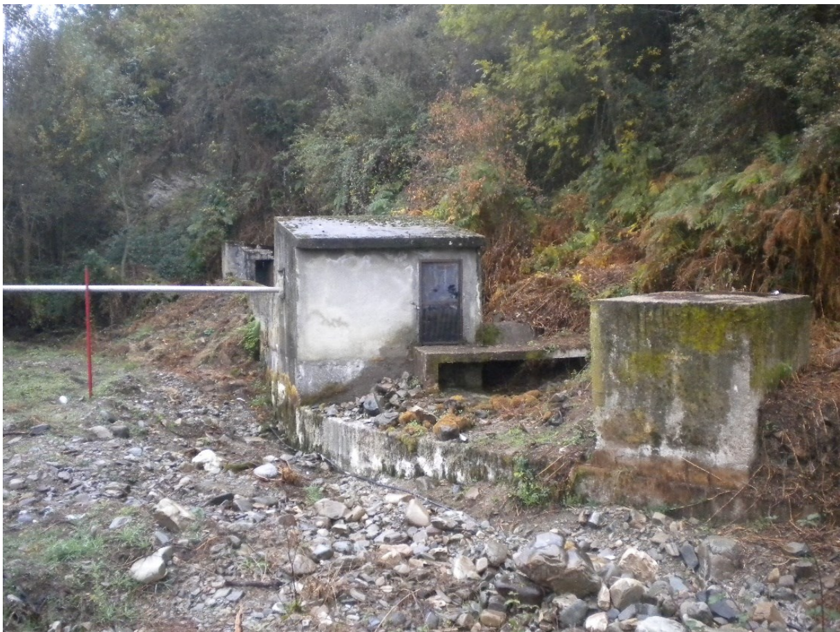
Figura 7.1. 6. Captación abastecimiento a Ezcaray en el río Oja.
