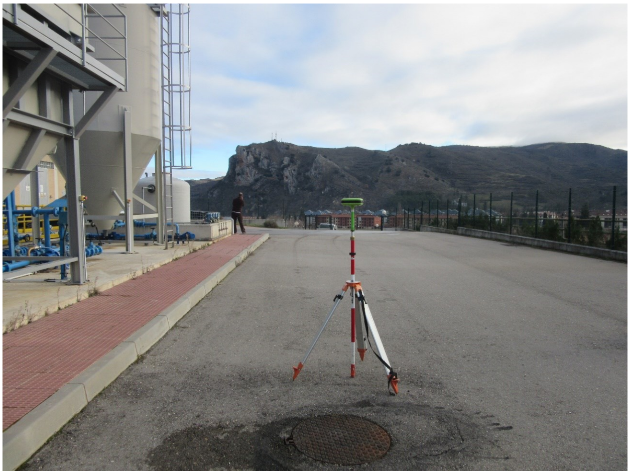
Figura 11.1.5 Piezómetro 2111-3-0068 en la ETAP de Ezcaray.
